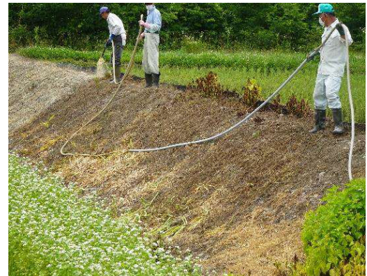
芝の吹き付け作業
