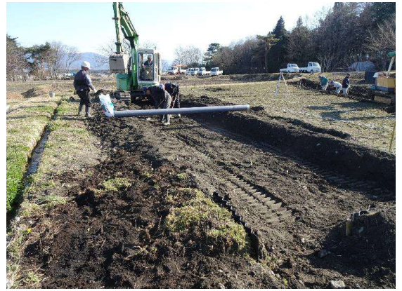
建設中のホタル水路
