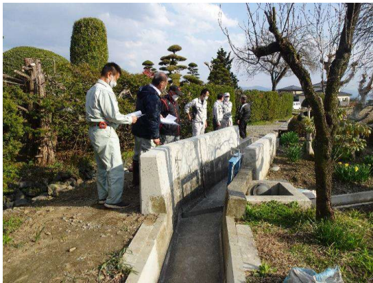
補修した水路
