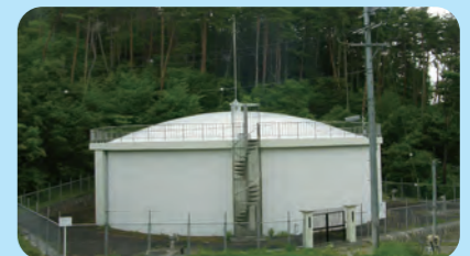
はいすい ●配水池
