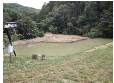
東日本台風災：土石流により土砂流入 決壊の寸前の危機（長野県）
